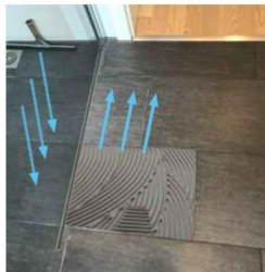
Feuchtwanderung aus dem Nassbereich unter keramischen Belägen
