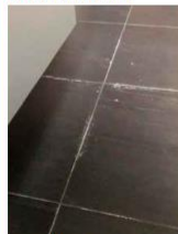
Wassertritt und Kristallisation von Salzen im angrenzenden Bodenbelag
