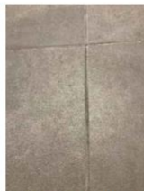
Verfärbungen/Verdunklungen der Fugen im Keramikbelag
