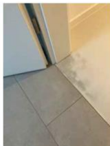
Wasserübertritt in angrenzende Räume -> Schädigung der Beläge, wie zum Beispiel: Stichtischplattenmassen, Teppich oder Design-Beläge
